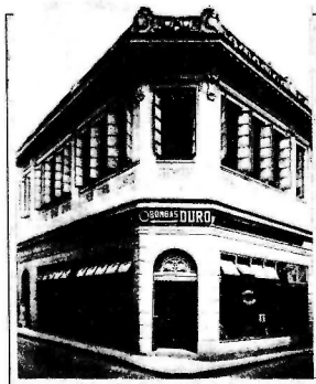
BOMBAS DE POZO PROFUNDO
